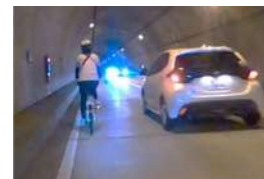
図-6 樺立トンネルの写真
