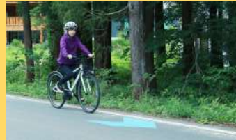
矢羽根型路面表示の整備
